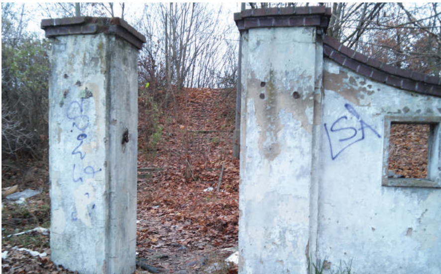
Fot. 8 Wejście na dawny stadion im. E. Szyca, fot. A.W. Brzezińska, 2014
