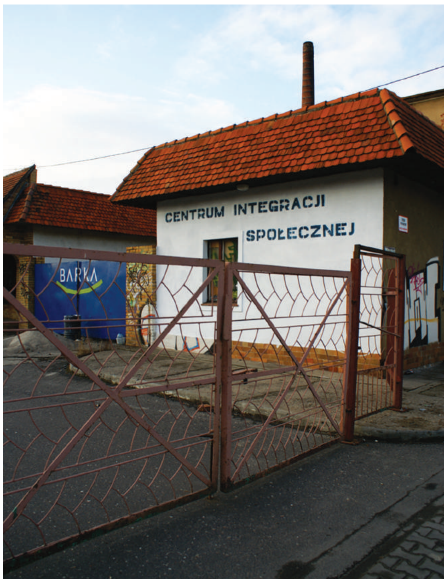
Fot. 7 Centrum Integracji Społecznej w dawnych budynkach fabryki konserw, fot. Bartosz Stańda, Poznań, 2010
