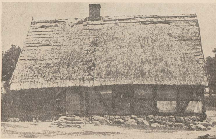
Ryc. 52. Chałupa we wsi Stara Święta, pow. Złotów. Przykład budownictwa szkieletowego. Fot. T. Wróblewski
