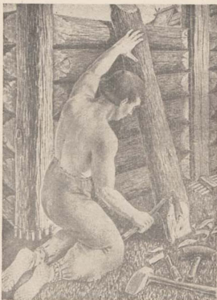
Ryc. 4. Sposób budowania ścian sumikowo-łątkowych w osadzie wczesnohistorycznej Biskupin. Muzeum Archeologiczne w Poznaniu
