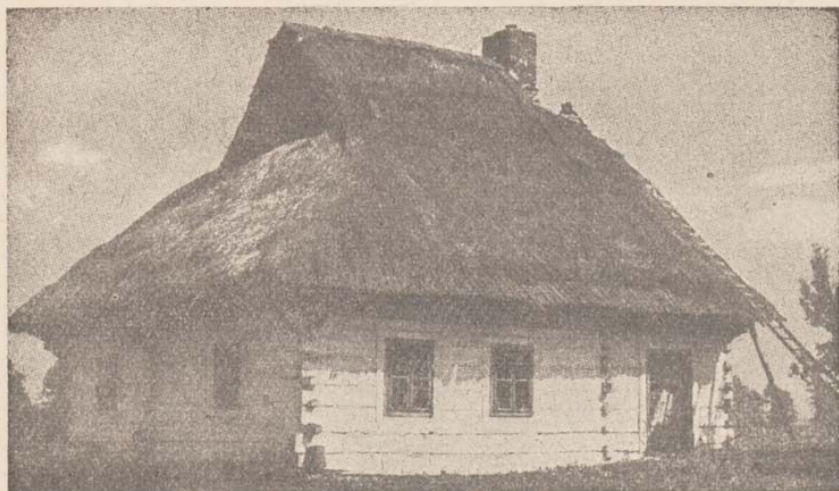
Ryc. 53. Chałupa z połowy XVIII w. w Siewierzu, pow. Warszawa. Przykład budownictwa zrębowego. Według F. Piaścika, fot. J. Dańda
