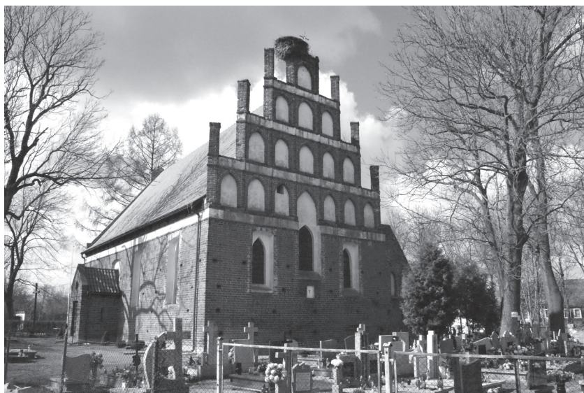
Fotografia 51. Kościół pw. św. Jerzego w Starej Kościelnicy. Ściana północna
