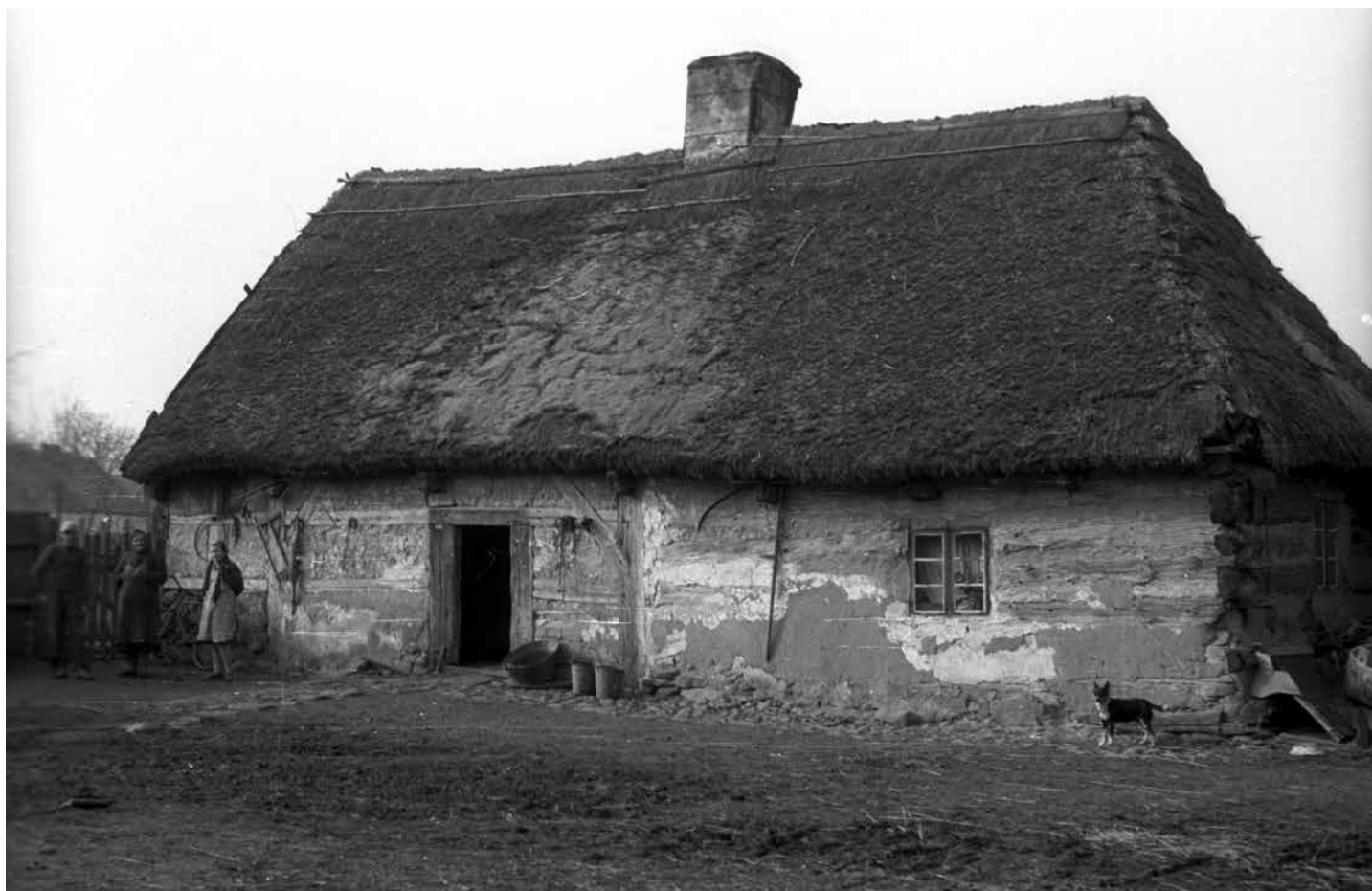
Autor: Tadeusz Wróblewski Rok i miejsce: 1957, Czarnków Tytuł: Chałupa o mieszanej konstrukcji Patronat zdjęcia: Katarzyna Wyrzykowska
