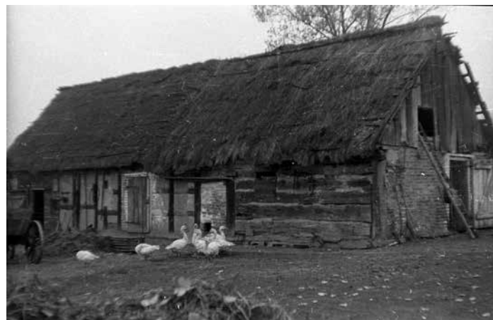
Autor: Józef Burszta Rok i miejsce: 1959, Piotrowo, pow. szubiński Tytuł: Budynek gospodarczy o mieszanej technice wykonania, kryty strzechą Patronat zdjęcia: Andrzej Trzeciak
